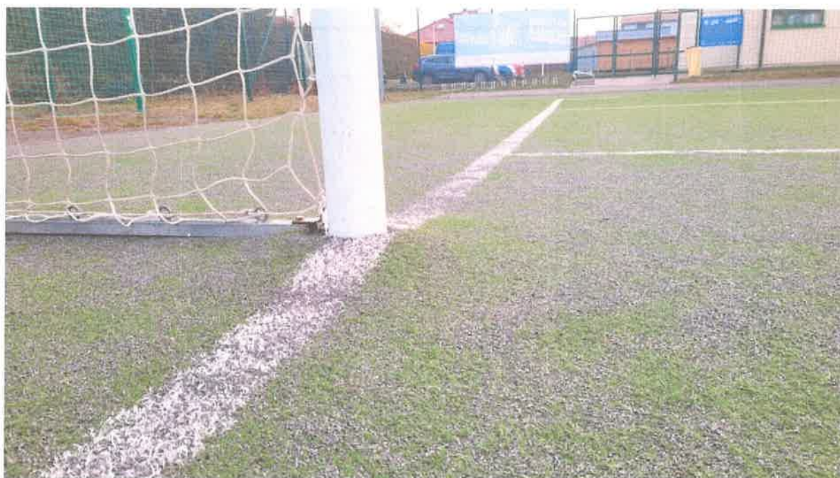
Zdjęcie nr 4 – widoczne podwyższenie nawierzchni przy słupie – do poprawy
